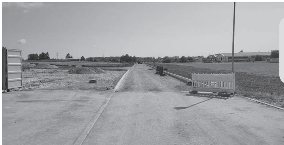
Erschließung Längenfeld-Süd im interkommunalen Gewerbegebiet
