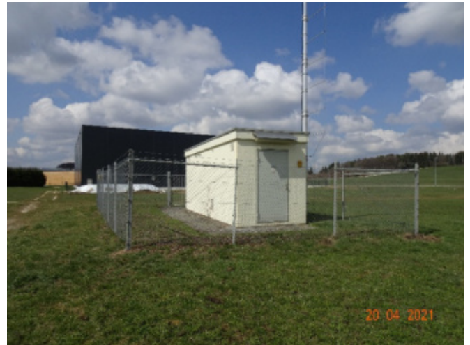
Foto 10: Versorgungsgebäude Ferngas der Stadtwerke Albstadt
