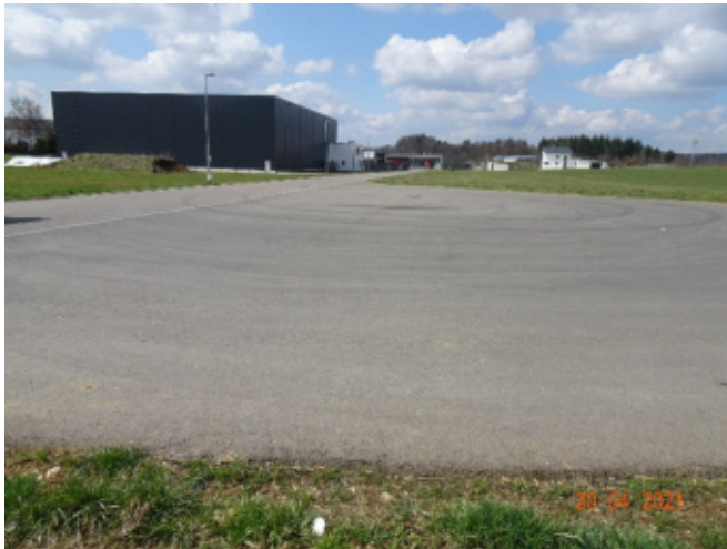
Foto 9: Wendehammer im Westen des Untersuchungsgebietes
