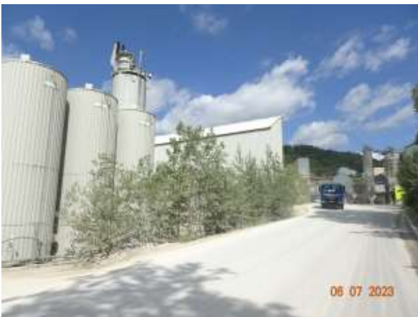
Foto 3: Betriebsfläche des Schotterwerks. Mittig im Bild stark eingestaubte Vegetation, im Vordergrund Verkehrsfläche des Betriebs. Blickrichtung Norden.
